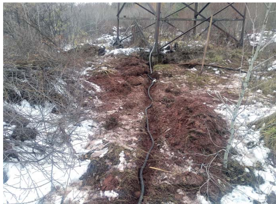
Укладка ПАРМА-ГГЗ в горизонтальной траншее
